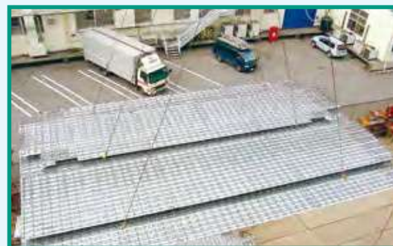
ユニット荷上げ
